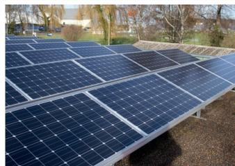
Bild 1 Solarpanels stehen unter Spannung, sobald die Sonne scheint.
