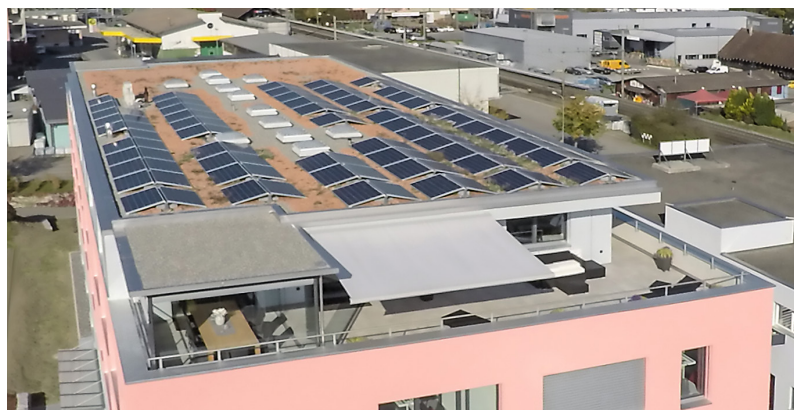
Die Photovoltaikanlage auf dem Dach liefert Strom für den e-Golf und auch für den täglichen Geschäftsbetrieb.
